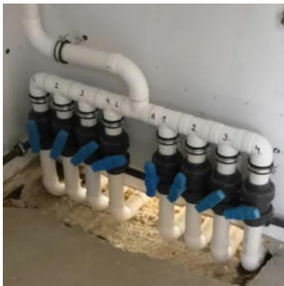
Bild 1: Sammler mit Kugelhähnen
