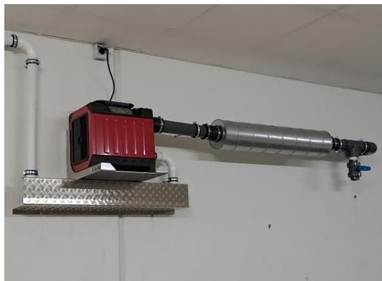
Bild 2: Radonsauger auf Konsole mit Schalldämpfer und Kondensatabscheider in der Fortluft und Rammschutz mittels Riffelblech-Verkofferung
