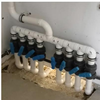
Bild 1: Sammler mit Kugelhähnen
