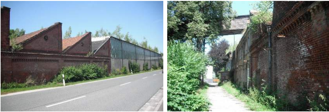
Abbildung 1: Objektsituation auf dem Projektareal in der Polenzstraße 48a in Lengsfeld
