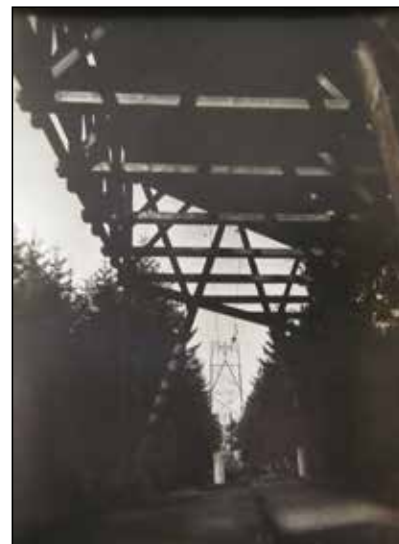
Foto der Seilbahn in einer Waldschneise mit Stützturm und Holzener Brücke zum Schutz einer Straßen- oder Wegekquerung, Karl Effenberg, Stadtarchiv
