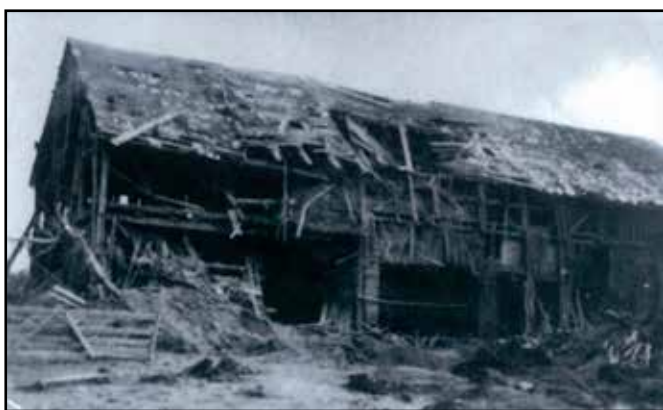
Fotos des schwer beschädigten Bauernhofes Eismann in Pechtelsgrün, Februar 1945; im Besitz von Fam. Kratzenstein
