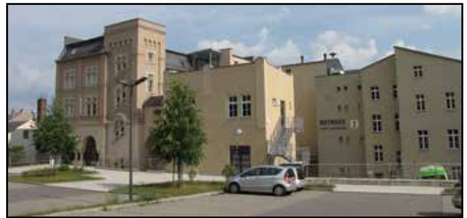
Die neugestaltete Rückseite unseres Rathauses nach der Fertigstellung
