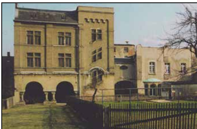
Das Bauteil D vor der Sanierung Foto: Friedrich Machold
