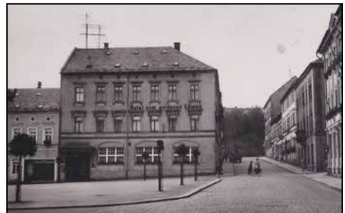
... und nach dem Umbau mit den großen Fenstern im Bereich des Restaurants.
