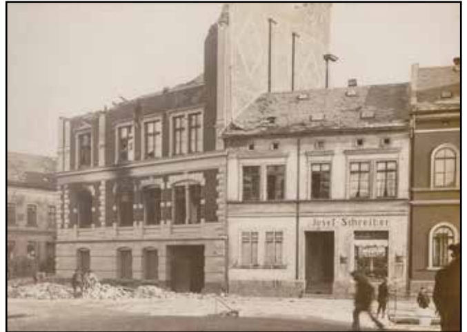
Das Fabrikgebäude Poststraße 1 / Ecke Auerbacher Straße der Fa. Baumgärtel (heute: Hotel „Lengenfelder Hof“) nach dem Großfeuer in der Nacht vom 5. zum 6. Februar 1927
