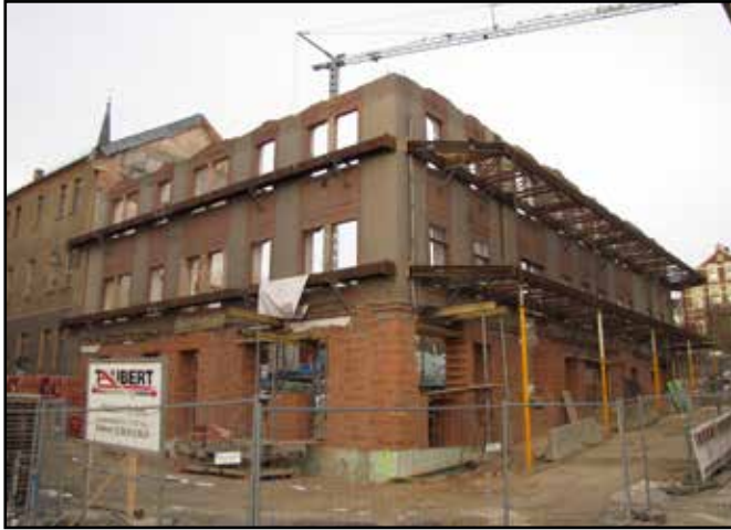
Hauptstraße 14 während des „denkmalgerechten“ Neubaus Foto: Friedrich Machold
