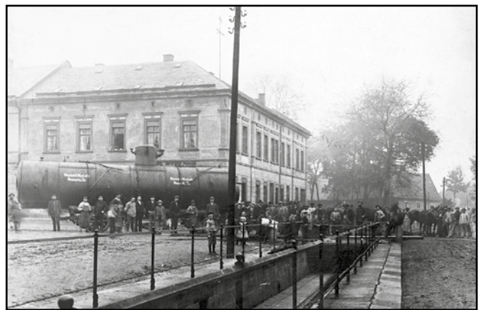
Der Dampfessel für die Fa. Baumgärtel, angefertigt von der Fa. Weichert & Wackwitz, Dampfesselfabrik in Neumark i. Sa., trifft ein.
