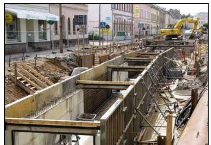
Bauarbeiten am Stadtbach im Bereich Markt Fotos: Helmut Wojtischek
