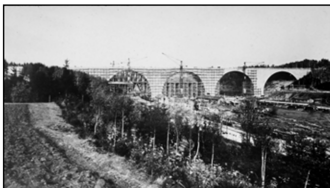
Die Autobahnbrücke bei Weißensand flussabwärts gesehen, erbaut 1937 bis 1938
