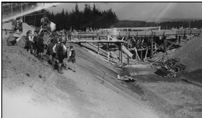
Bau einer Autobahnunterführung für einen Wirtschaftsweg oberhalb von Waldkirchen-Schönbrunn
