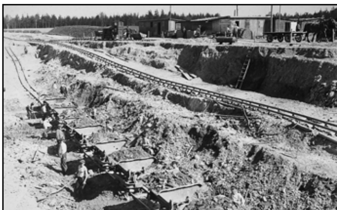
Schachtarbeiten für den Autobahnbau im Bereich der Straße Waldkirchen-Oberheinsdorf
