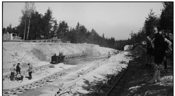
Ausschachtungsarbeiten für den Autobahnbau im Bereich der Straßenquerung Waldkirchen-Schönbrunn nach Unterheinsdorf
