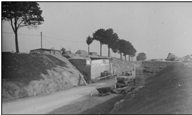
Bau der Brücke der Reichsautobahn am „Kalten Feld“ im Bereich der Landstraße nach Reichenbach
