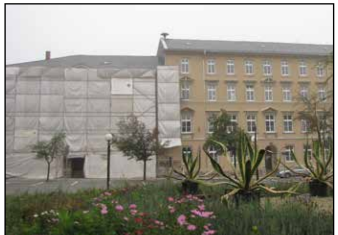
Rathaus (Hauptstraße 1) und Hauptstraße 3 während der Fassadengestaltung 2010 Foto: Friedrich Machold
